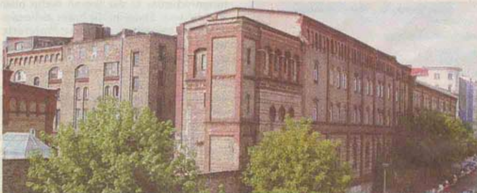
Einen markanten Anblick im Szeneviertel Prenzlauer Berg bieten die im 19. Jahrhundert errichteten Gebäude der ehemaligen Königstadt-Brauerei. Bild: Klinkenberg Architekten
